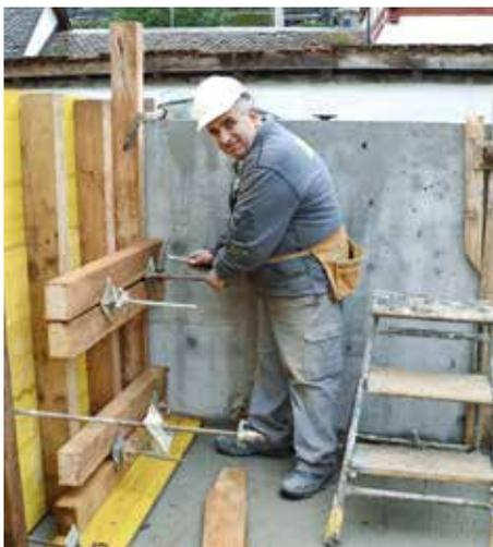
Die Lage des Anbaus stellte hohe Anforderungen an uns bzw. die von uns zu erstellenden Unterfangungen. Bei Unterfangungen wird das Fundament des «alten» Gebäudeteils mit Beton unterfüttert, damit es beim Erstellen der unmittelbar daneben liegenden Baugrube keine Destabilisierung des Gebäudes gibt.
