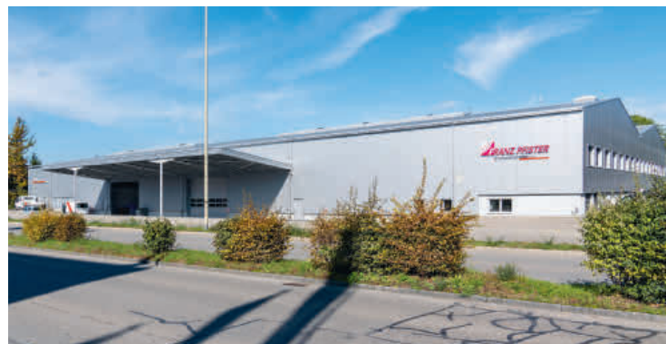
Ansicht der neuen Halle mit Einfahrtstor und Büros auf der rechten Seite.
