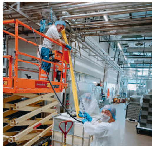
Mitarbeiter der EX TEAM AG Kanalservices befreiten an einem Wochenende eine industrielle Leitung von einer Verstopfung.
