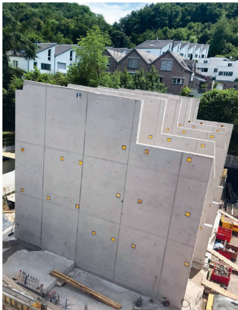
Die in den ausgeschalteten Wänden ersichtlichen Aussparungen dienen dem Einsetzen von Auflagerkonsolen für die Holzelementdecken.
