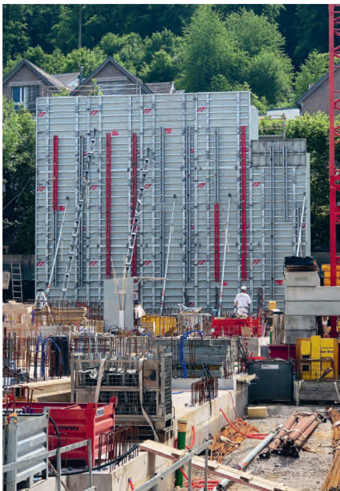
Erstellung von 10.50 Meter hohen Haustrennwänden in einem Guss.
