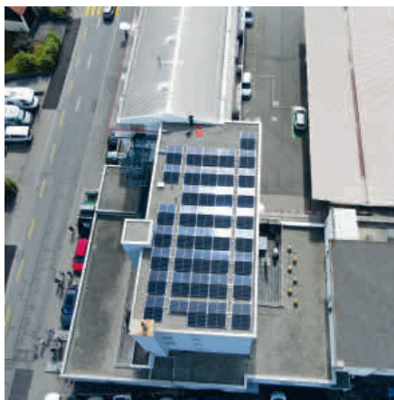
Photovoltaikanlage auf dem Dach unseres Bürogebäudes an der Tägerhardstrasse in Wettingen.
